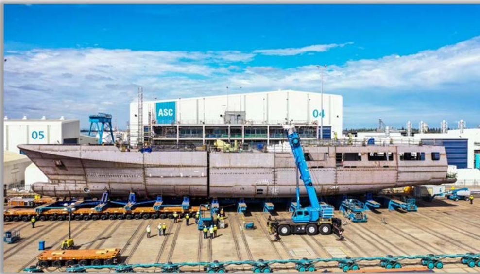
รูปภาพ การเชื่อมต่อโครงสร้างเรือชั้น Arafura (Commonwealth of Australia 2020)
